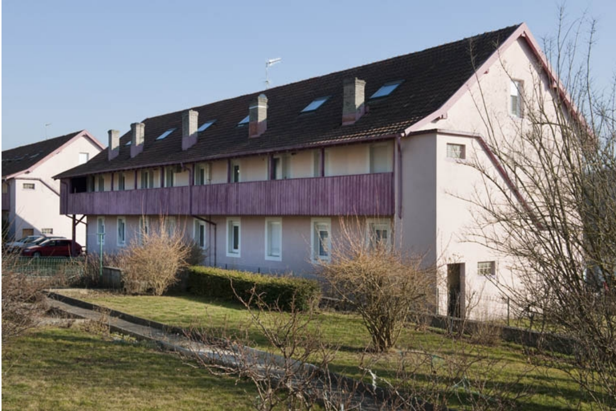
Immeuble d'habitation vu de trois quarts arrière..
