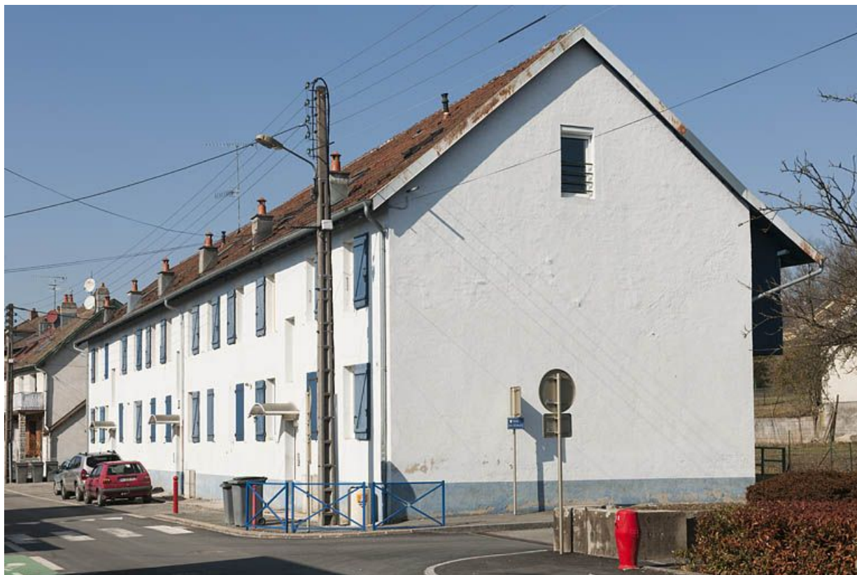
Immeuble de 12 logements vu depuis le sud-est.
