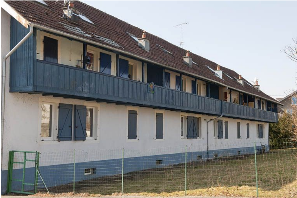
Immeuble de 12 logements. Façade postérieure.
