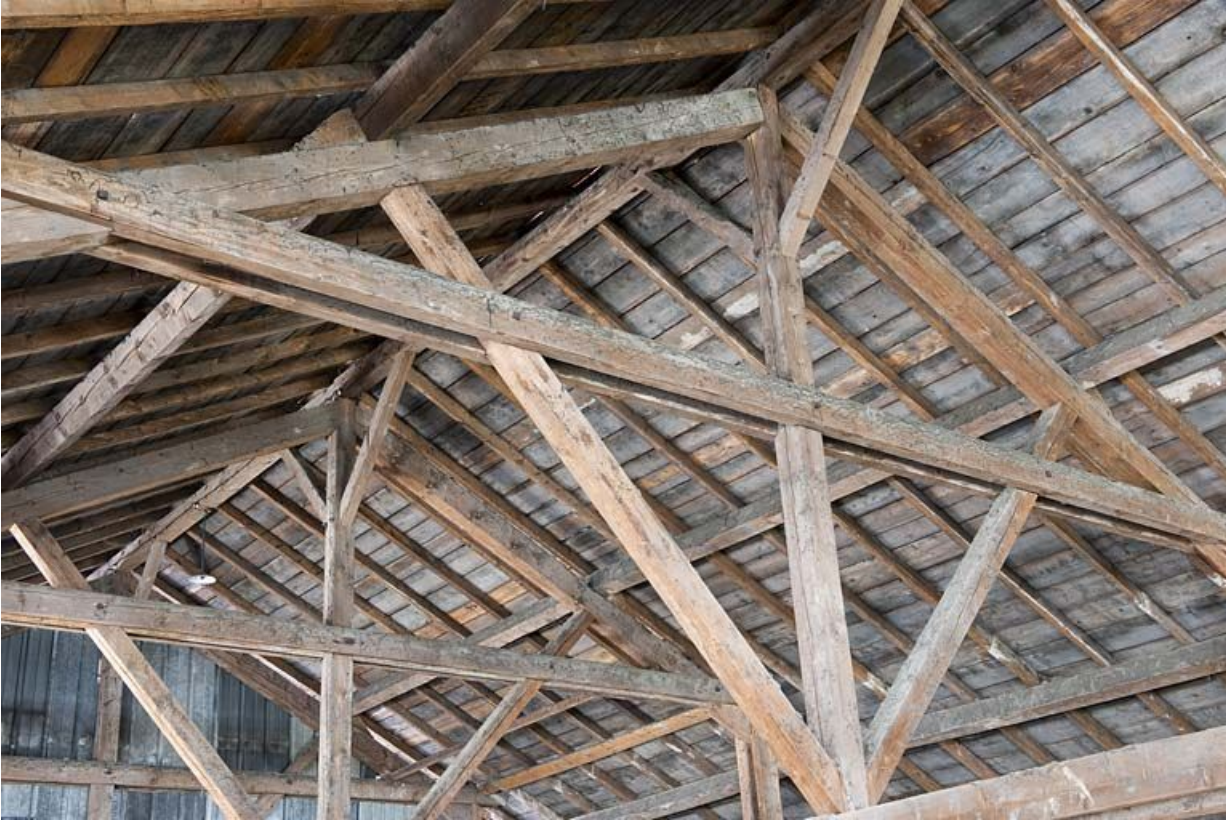
Entrepôt industriel. Détail de la charpente.
