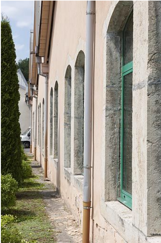
Façade ouest de l'atelier d'outillage.
