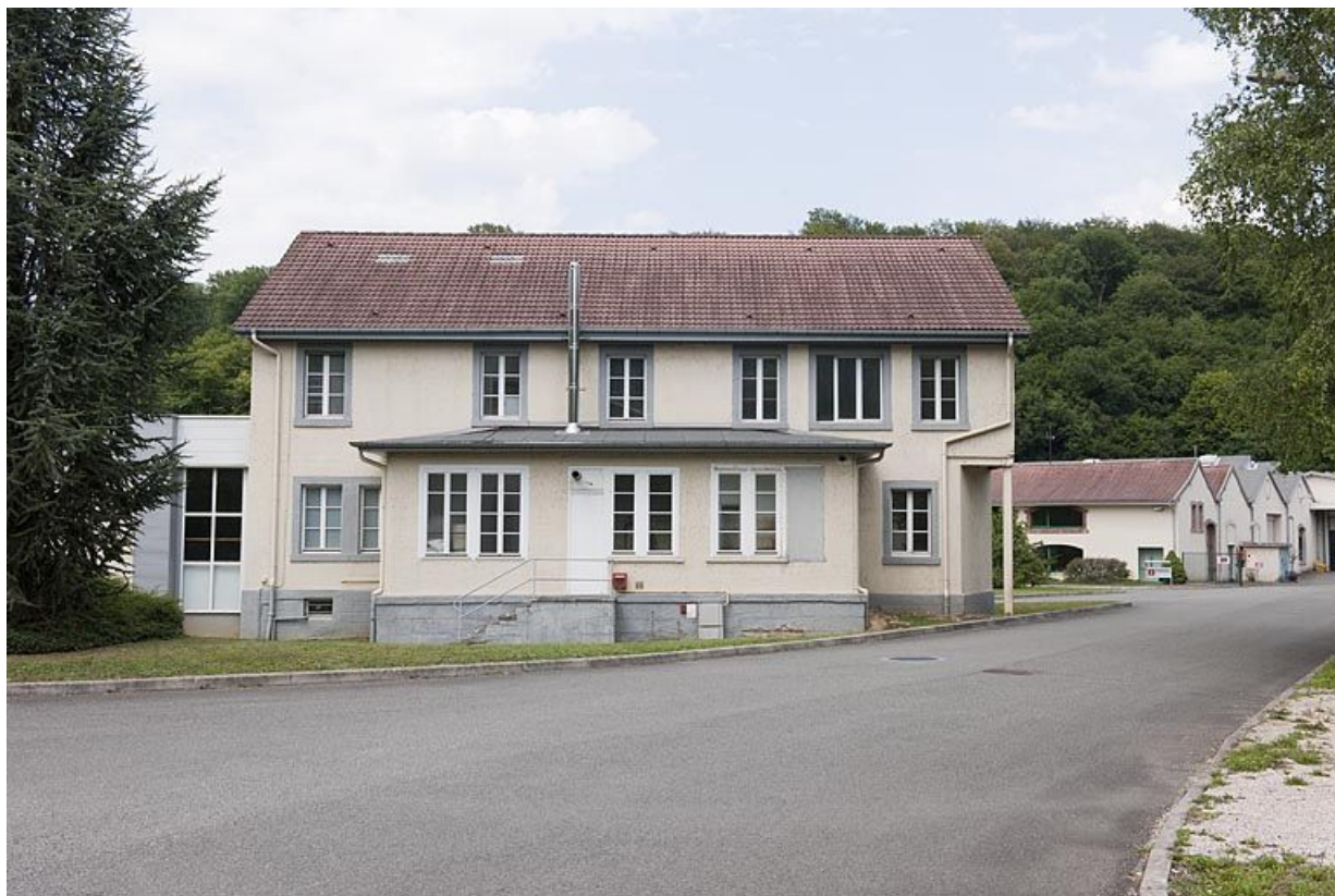
Ancien bâtiment des bureaux. Façade sud.
