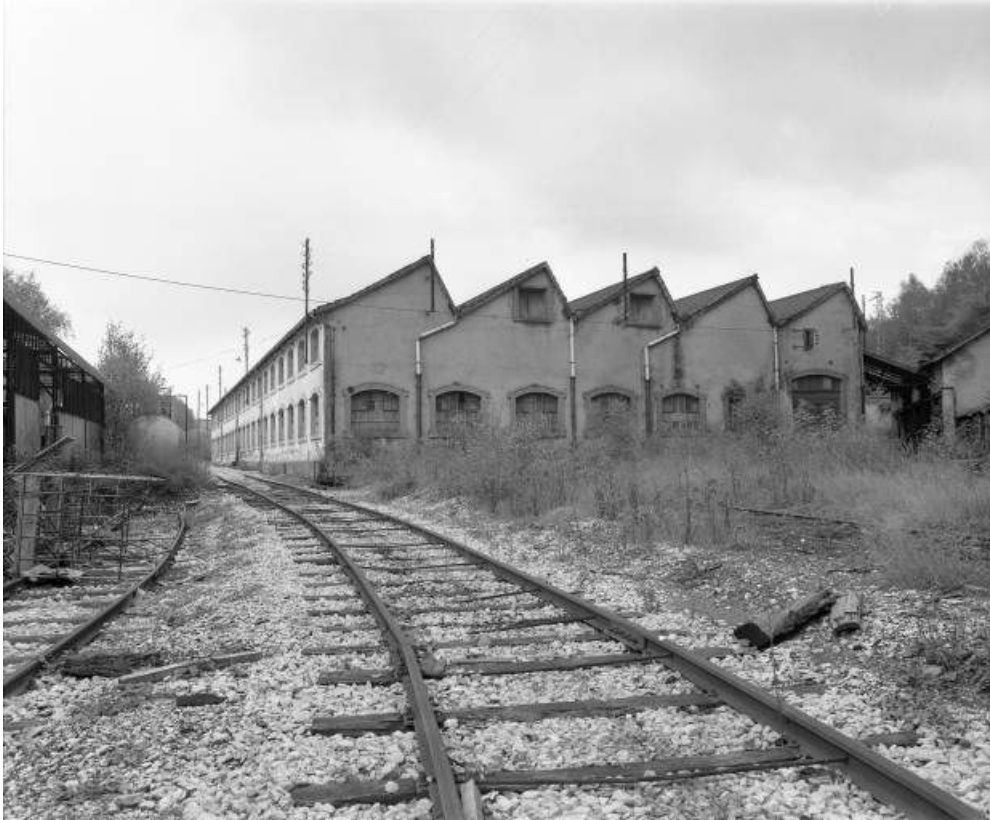
Atelier des pompes depuis l'ouest en 1981.
