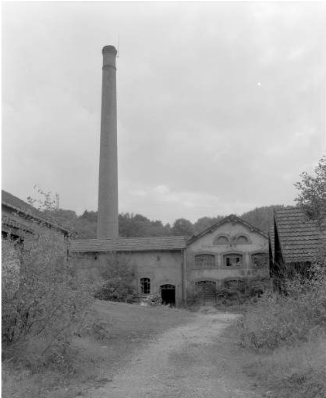
Façade nord de l'atelier de galvanisation en 1981.
