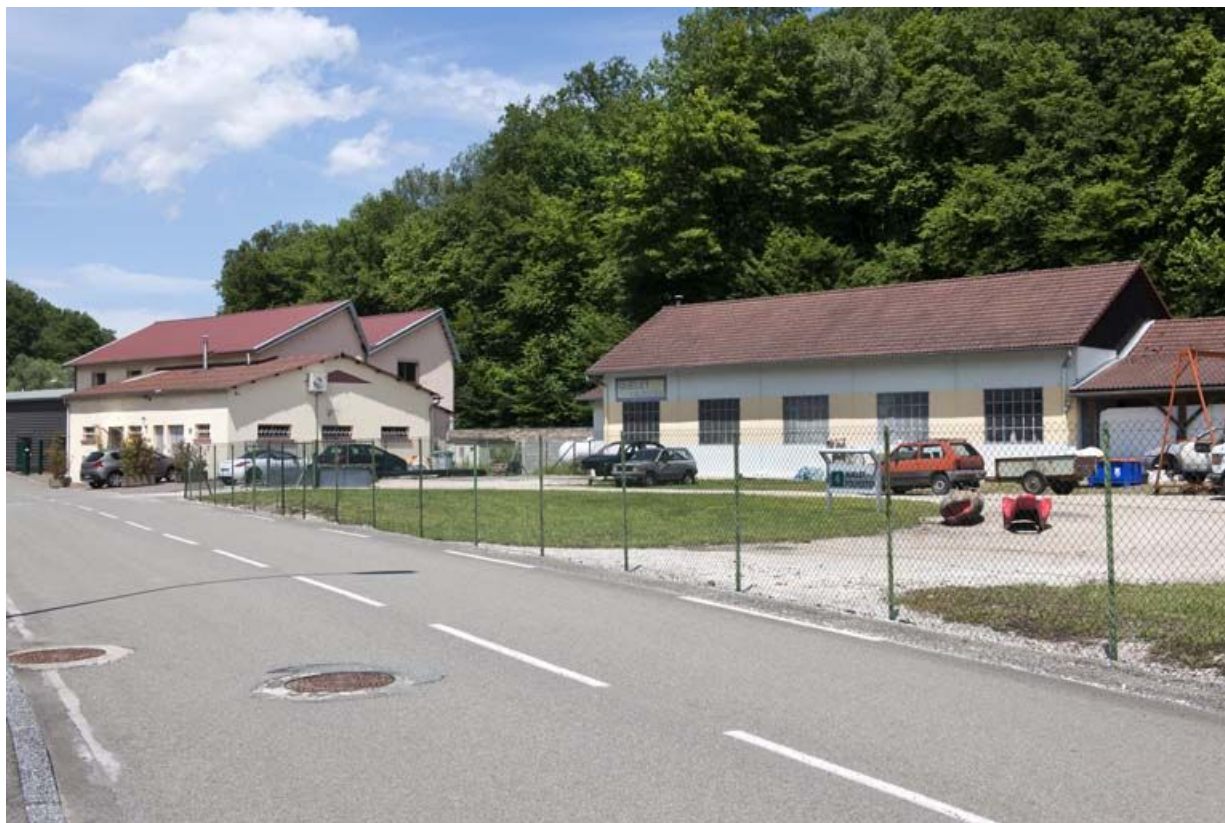
Vue rapprochée depuis le nord-ouest.
