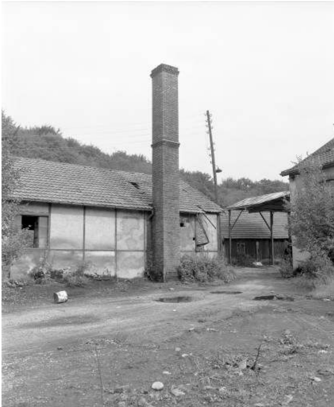
La chaufferie et sa cheminée en 1981.
