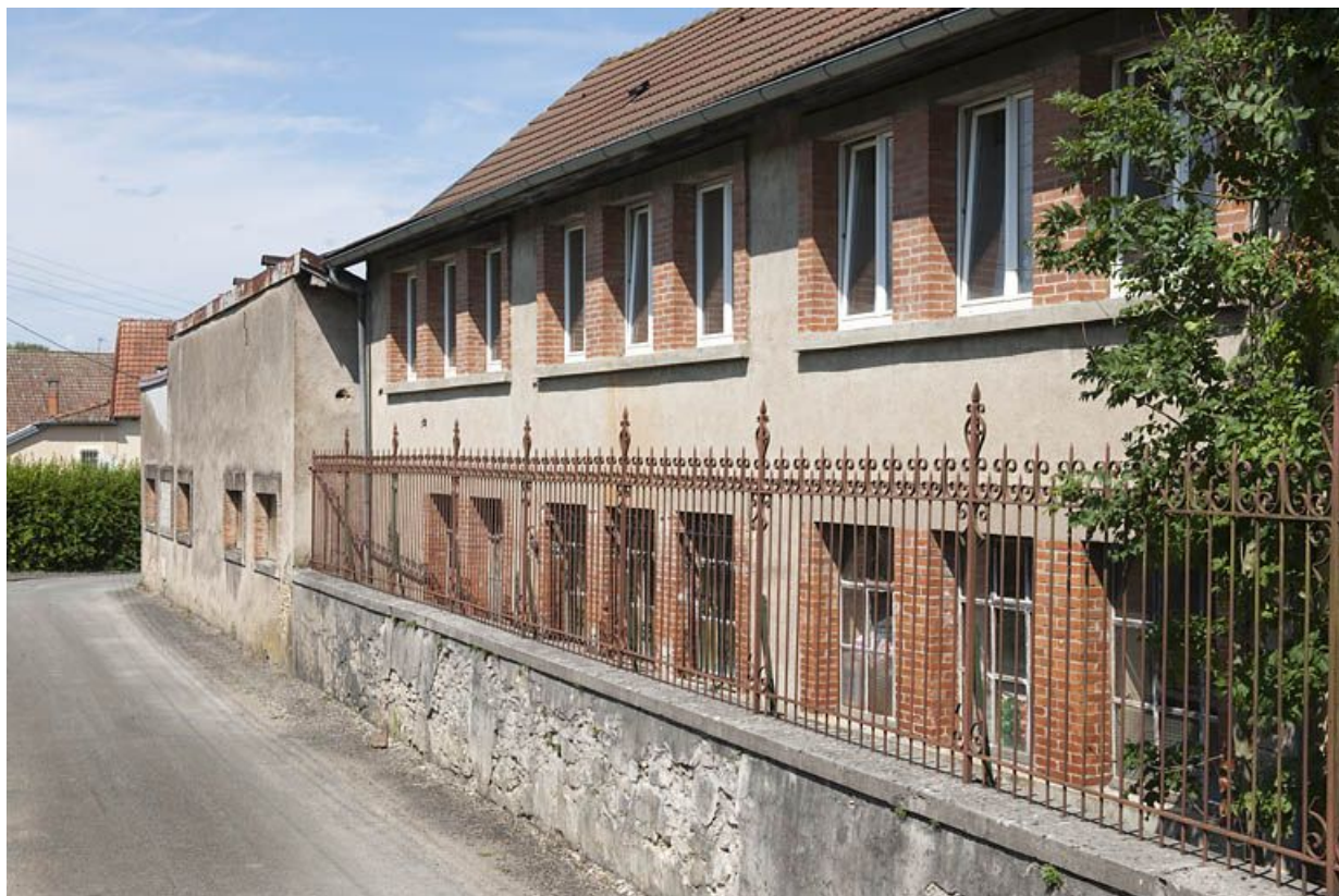
Façade ouest d'un bâtiment industriel (atelier ?).
