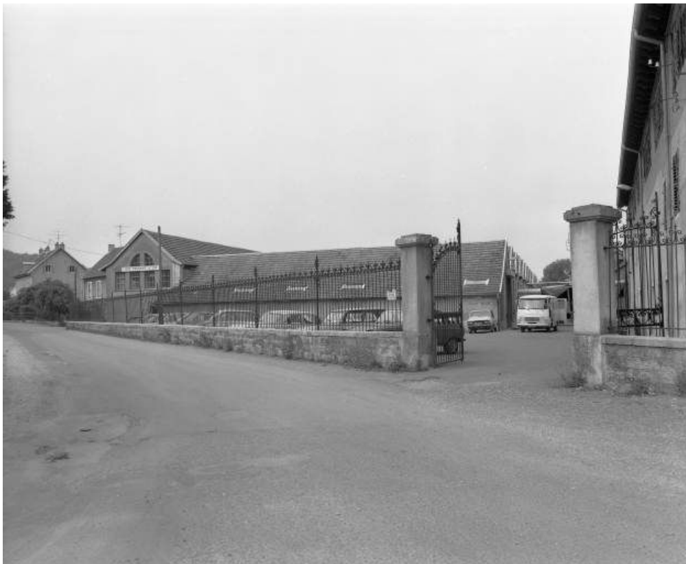
Ateliers en rez-de-chaussée depuis le sud en 1981.
