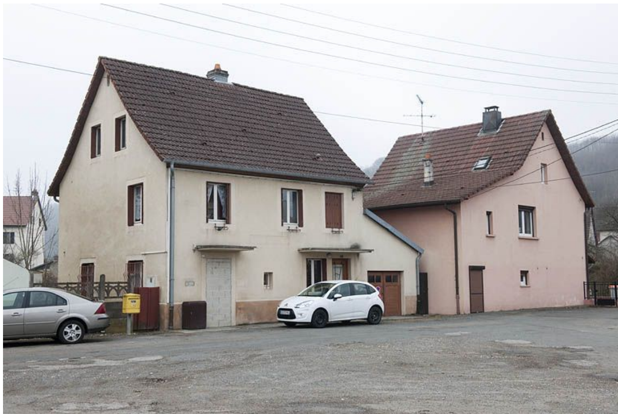
Maisons individuelles rue de la Poste.
