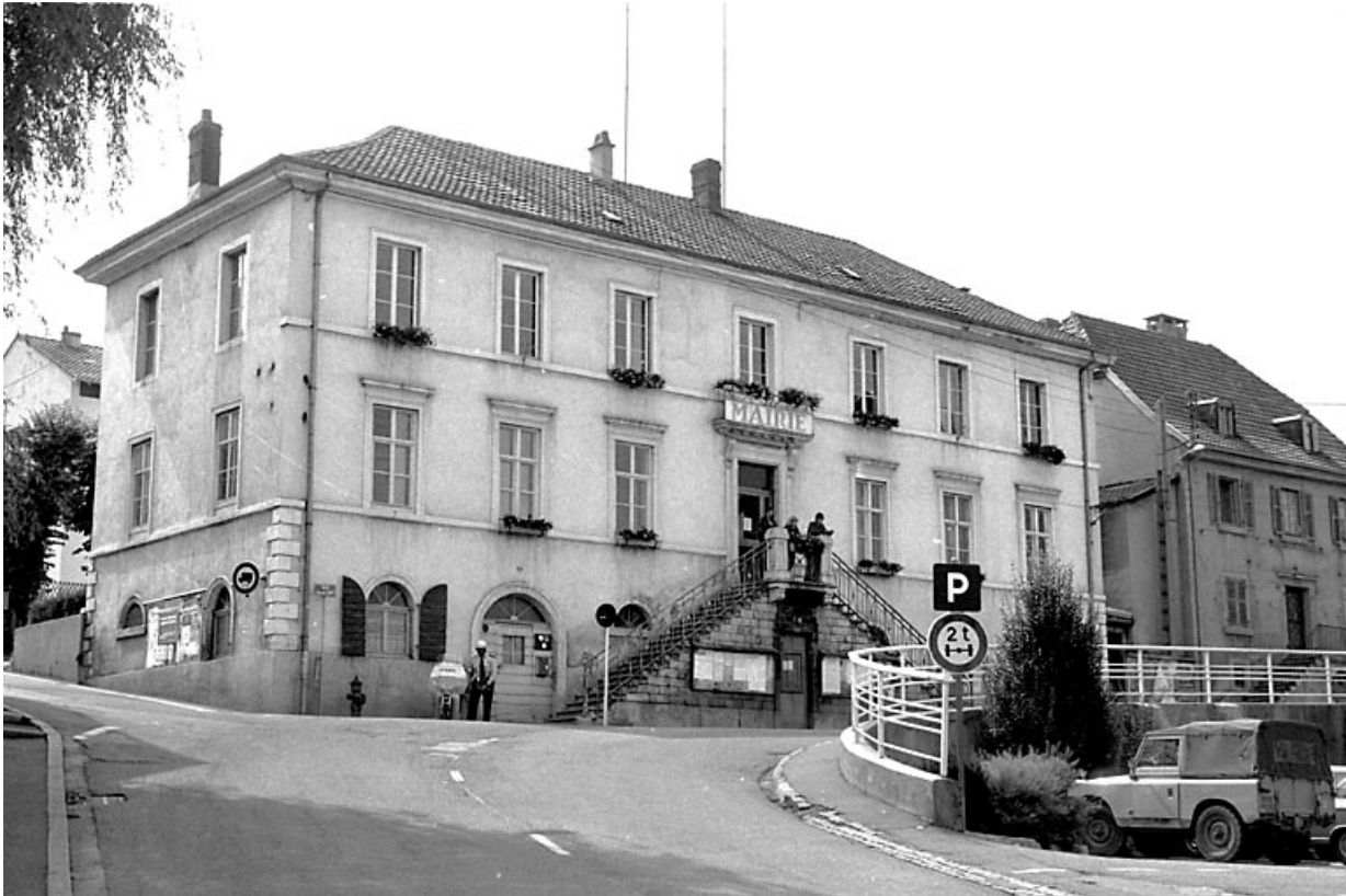
Façades antérieure et latérale gauche.
