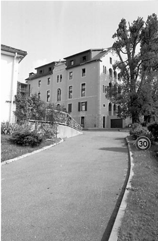
Façades antérieure et latérale droite.
