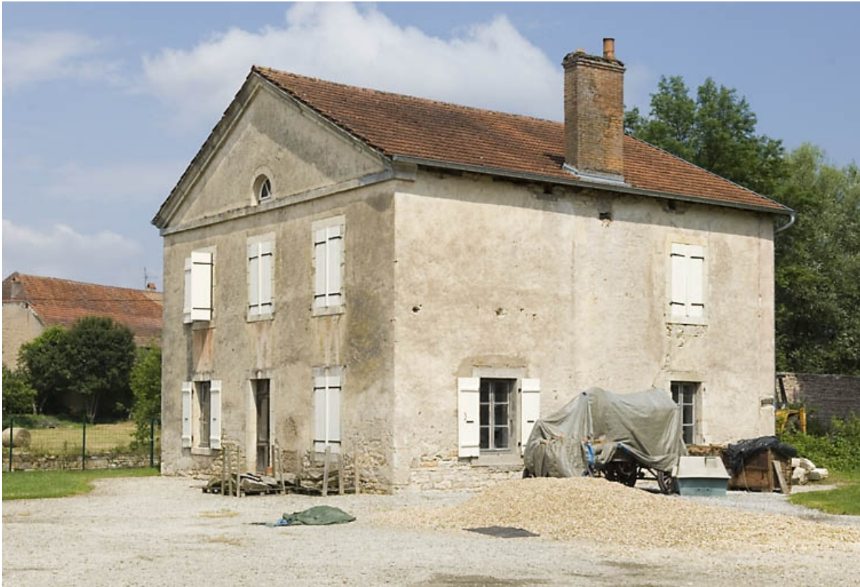
Logement patronal vu de trois quarts en 2008.
