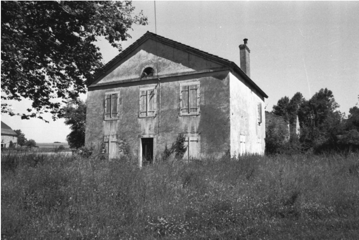
Logement patronal. Vue de trois quarts en 1981.
