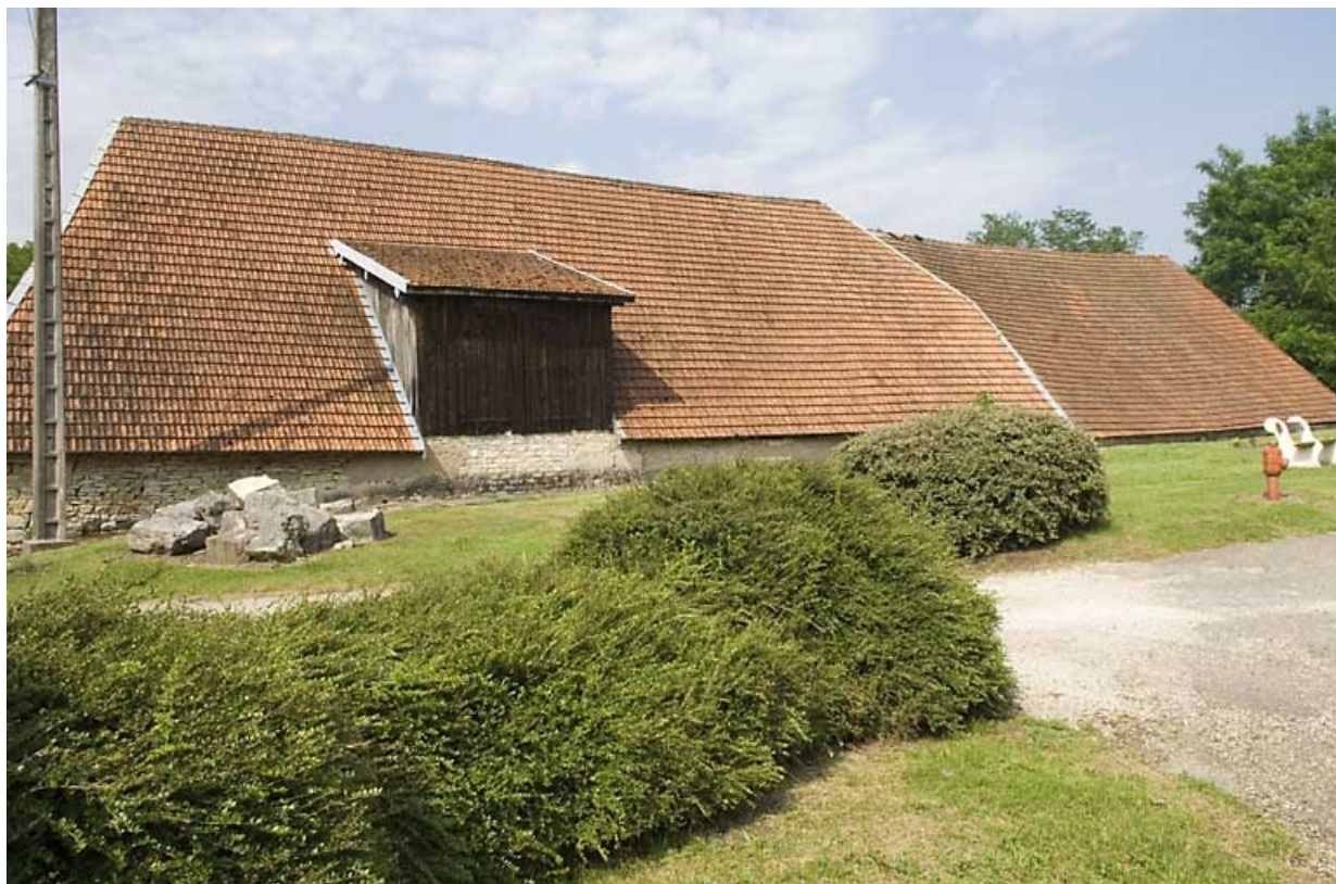
Vue d'ensemble de la halle à charbon.
