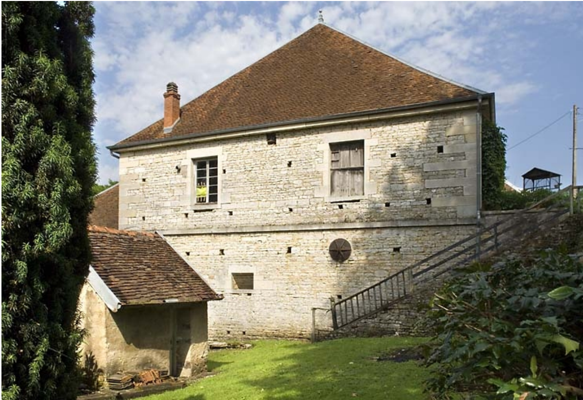
Façade ouest du haut fourneau.
