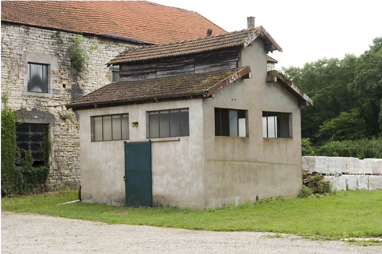
Bâtiment à usage indéterminé.
