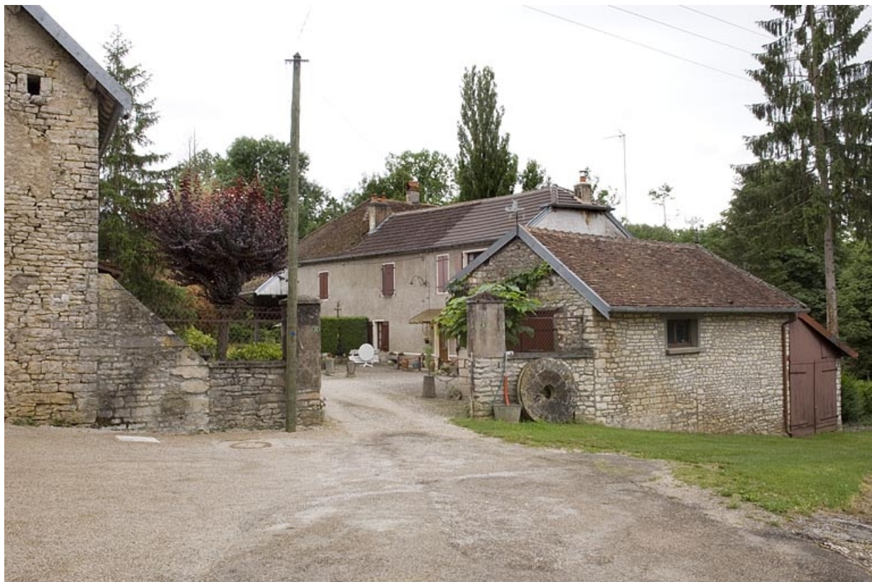
Vue d'ensemble depuis la rue.
