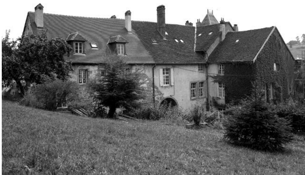
Façade postérieure : vue de trois quarts droit.
