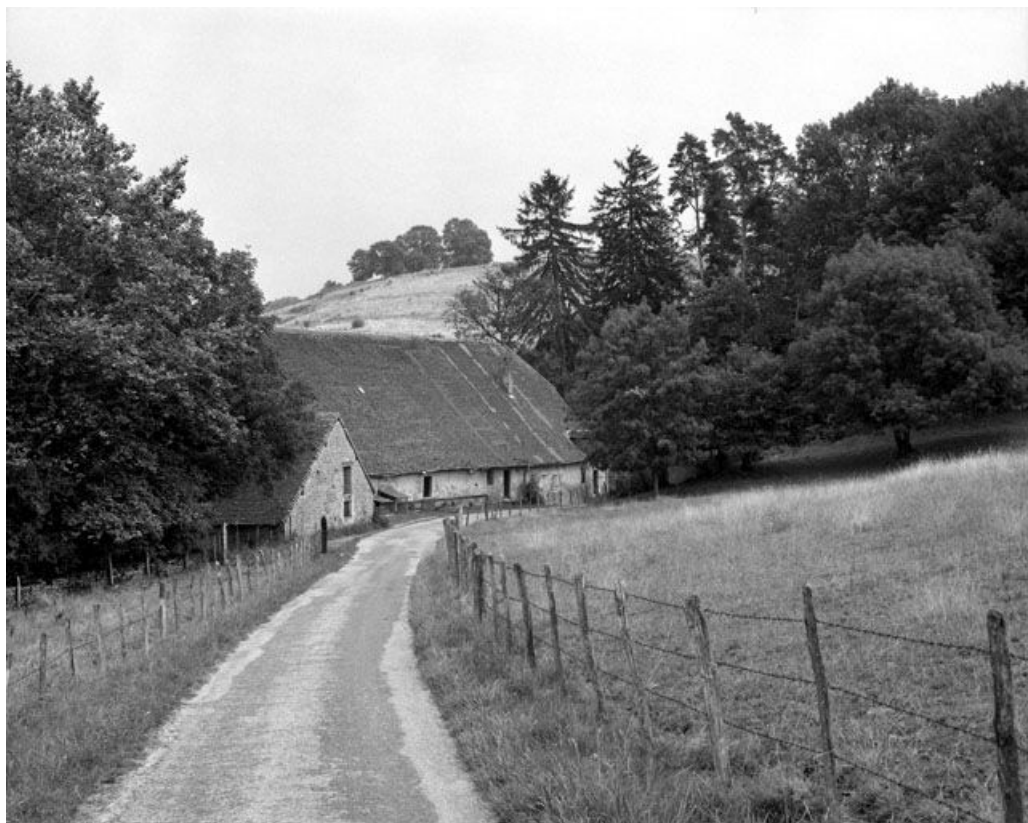
Les parties agricoles vues depuis l'ouest.
