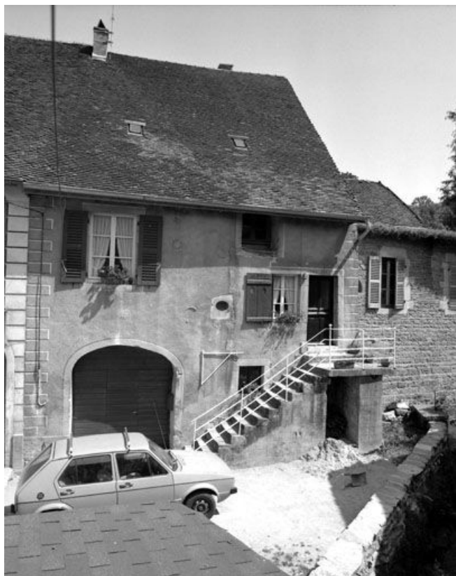
Façade antérieure vue de face.
