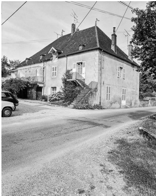
Façades antérieure et latérale droite.
