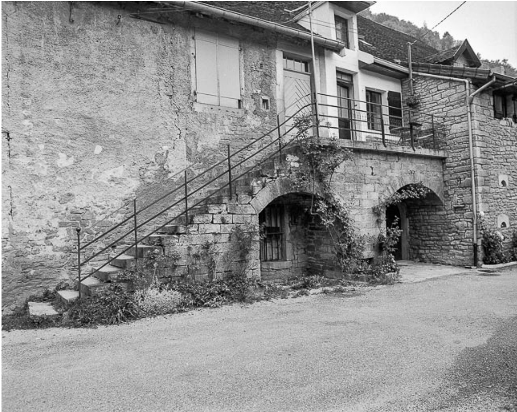
Façade antérieure : escalier à gauche de l'avancée.
