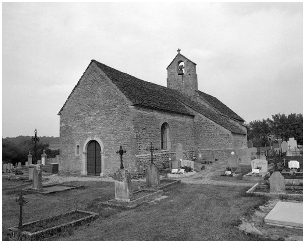
Façade antérieure et face droite.
