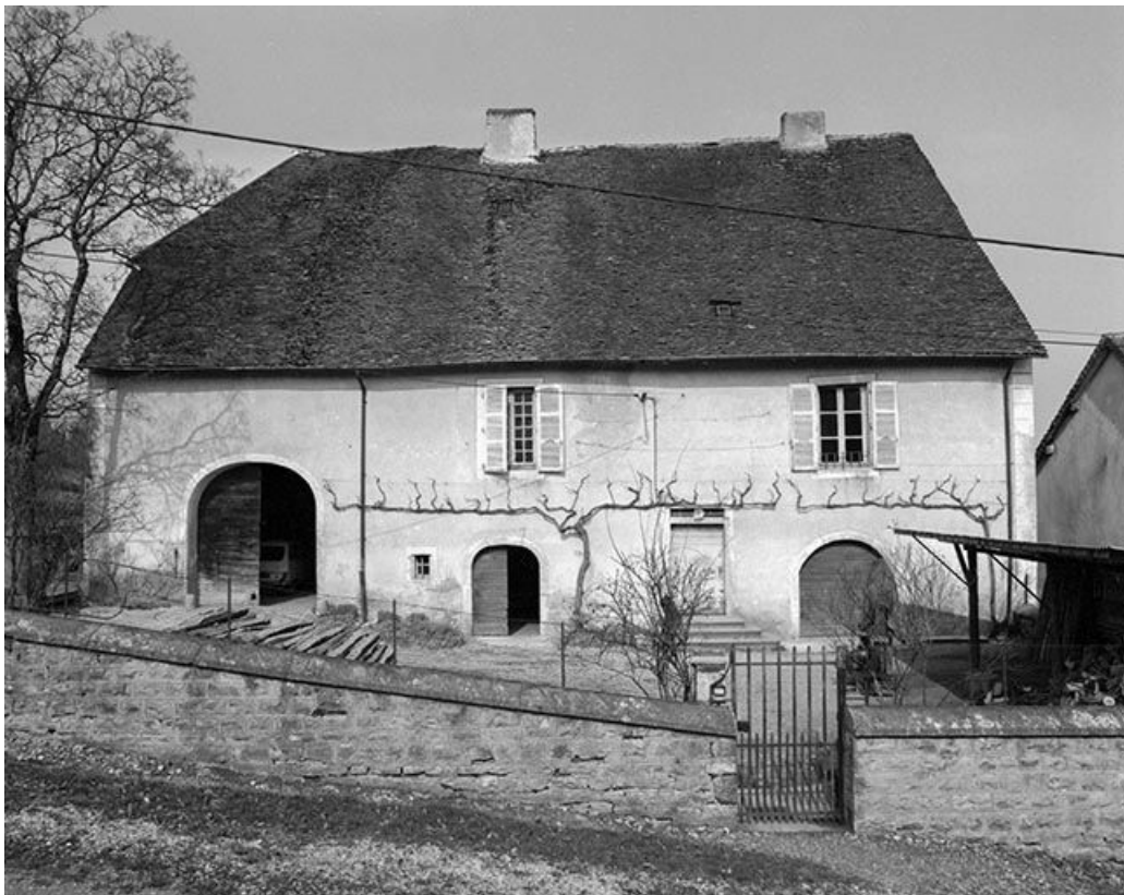
Façade antérieure, vue de face.
