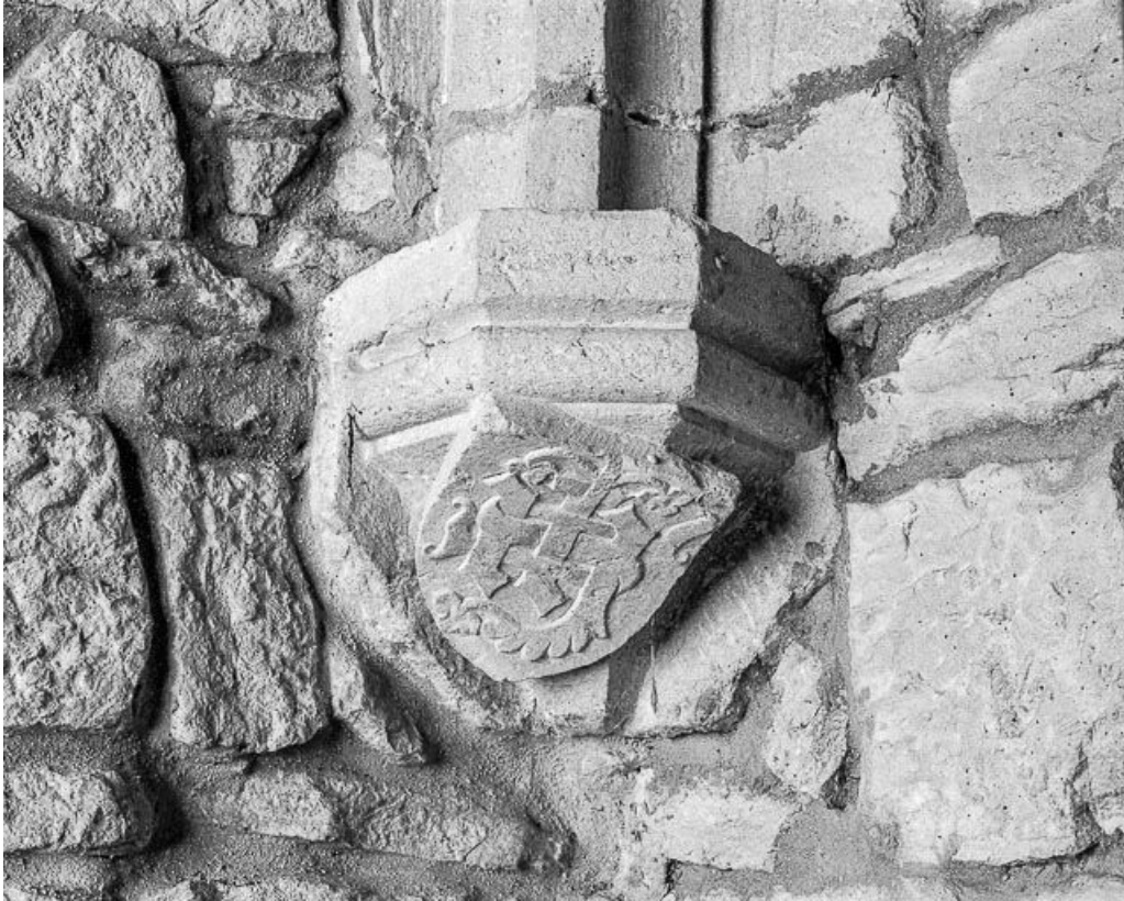
Première chapelle droite : culot sud-ouest.
