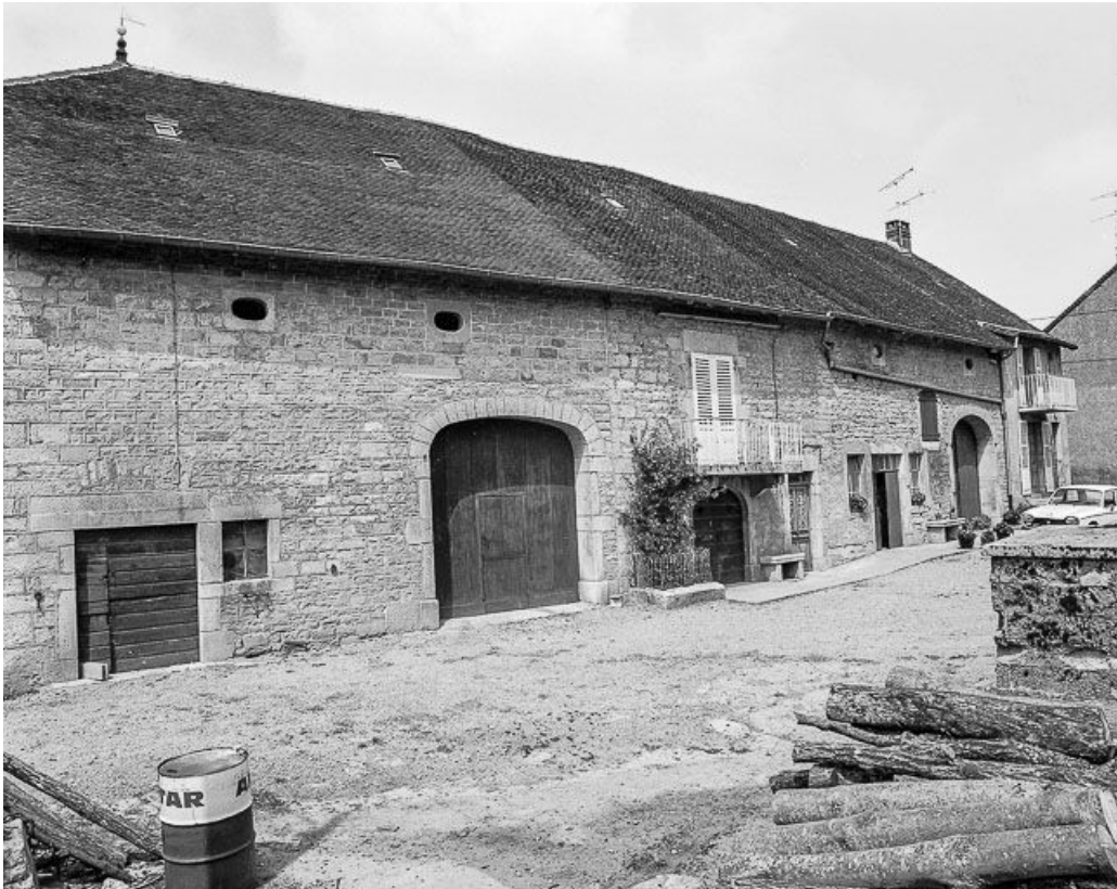
Façade antérieure vue de trois quarts gauche.
