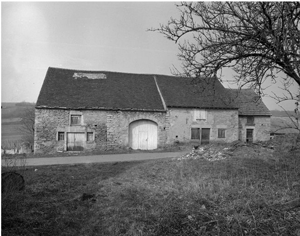
Façade antérieure, vue de face.
