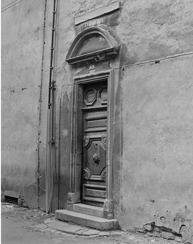
Façade latérale, porte d'entrée.
