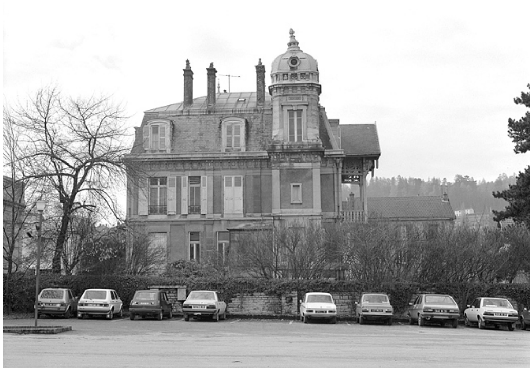
Façade latérale droite.
