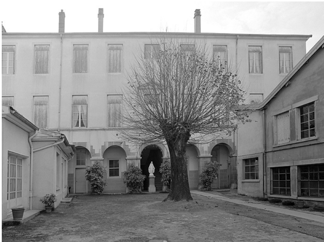
Bâtiment annexe, façade sur la cour.
