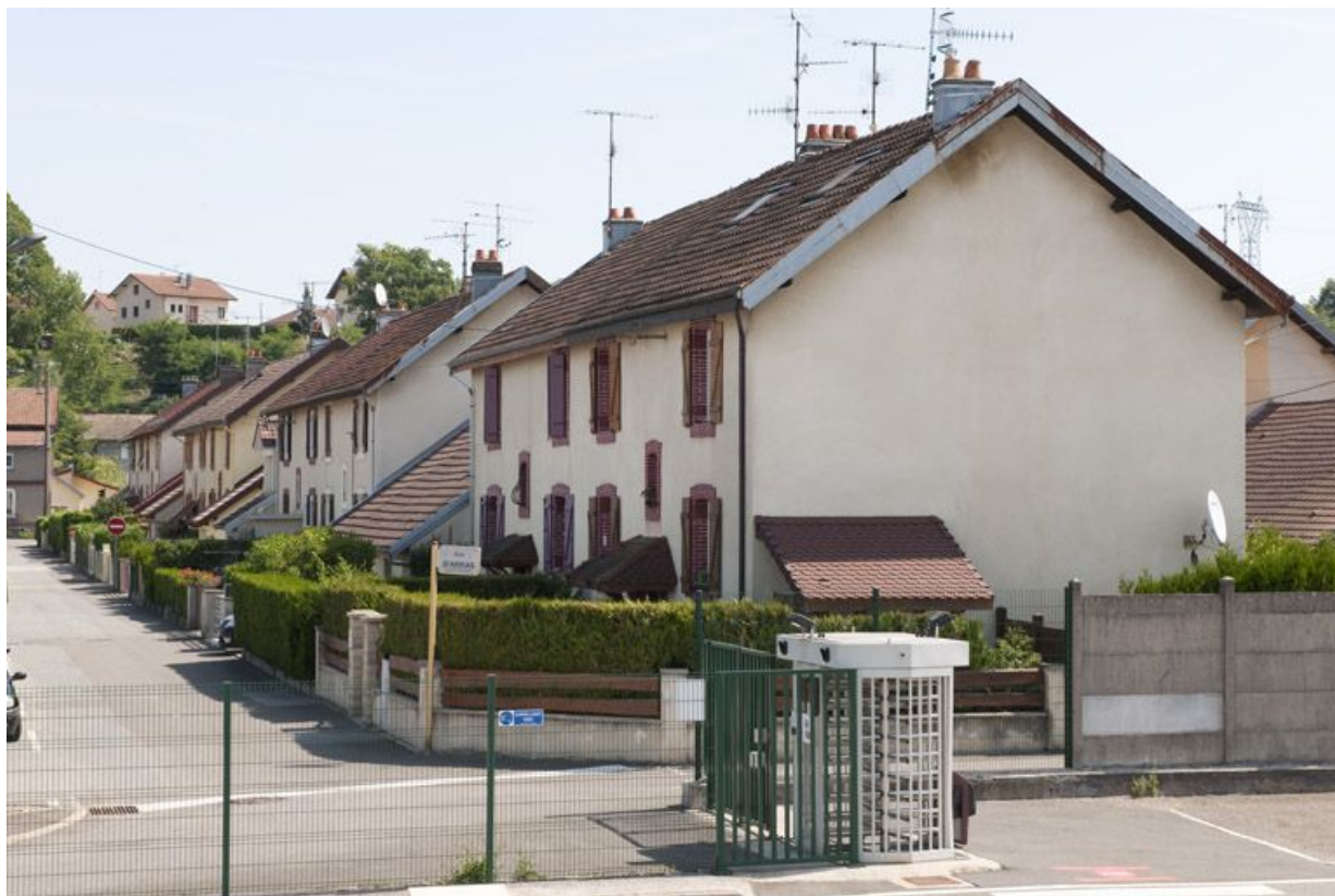
Vue d'ensemble de la rue d'Arras.
