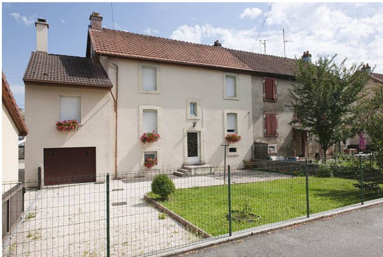
Rue de Verdun. Façade postérieure d'une habitation.
