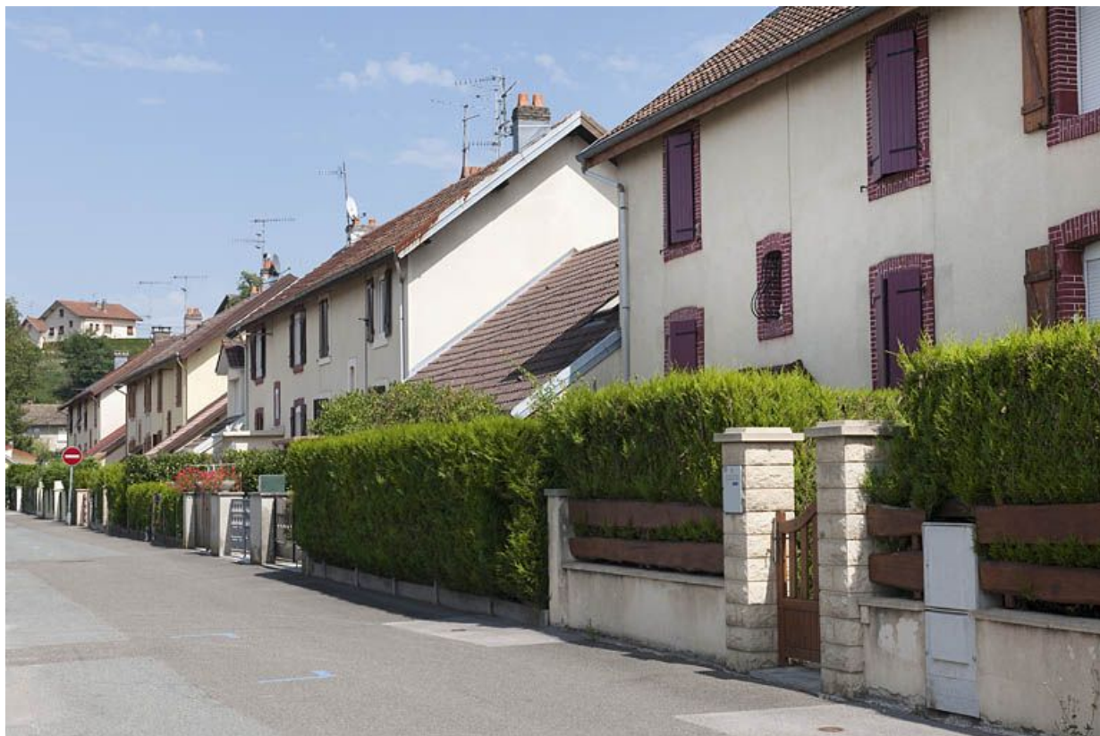
Rue d'Arras. Façades vues de trois quarts.
