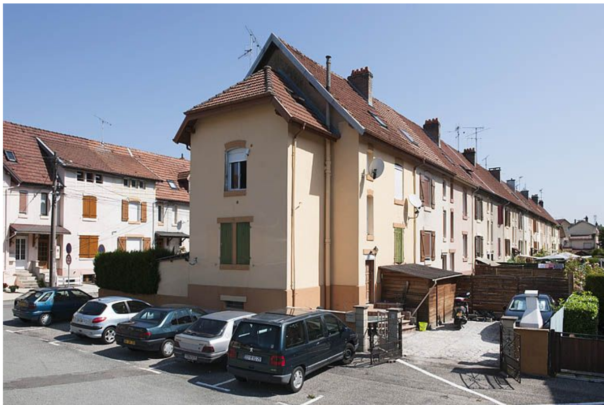
Immeuble rue de Flandres depuis le sud-ouest.
