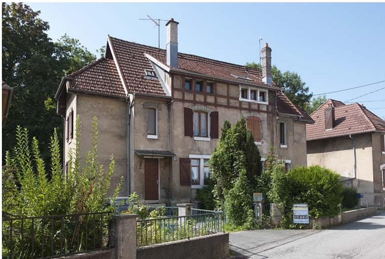
Maison jumelée rue de Flandres.
