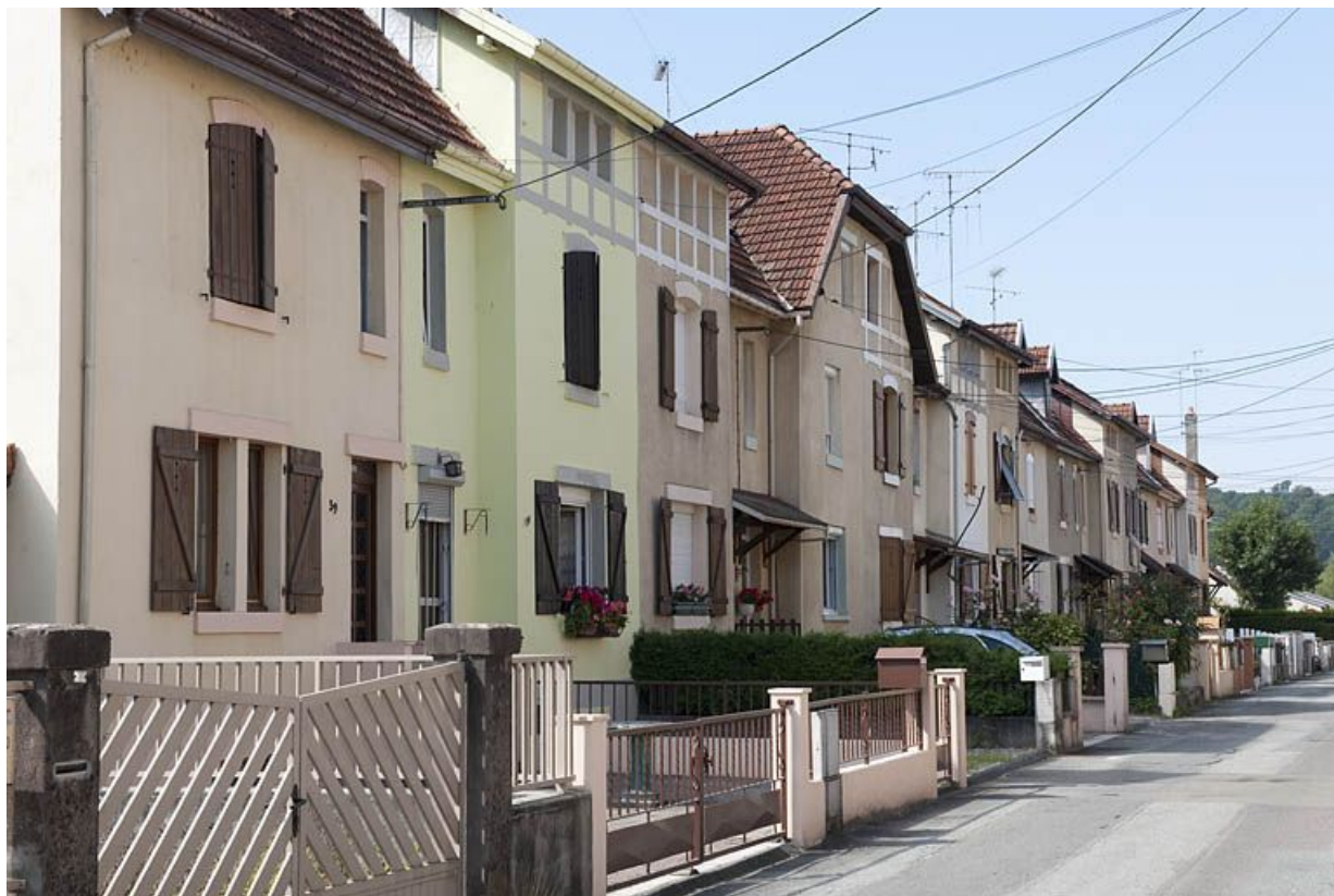
Rue de Somme. Façades nord.
