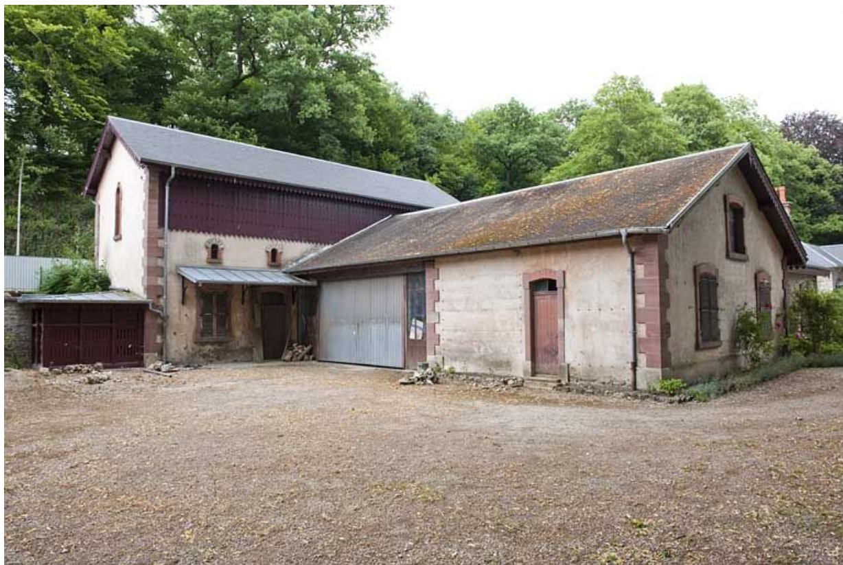
Communs vus depuis le nord-ouest.
