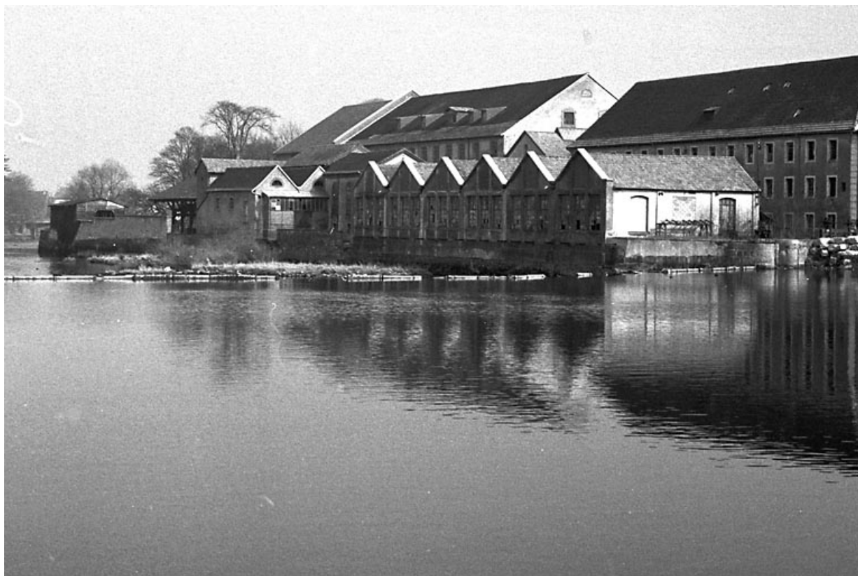
Vue d'ensemble depuis l'amont en 1983.
