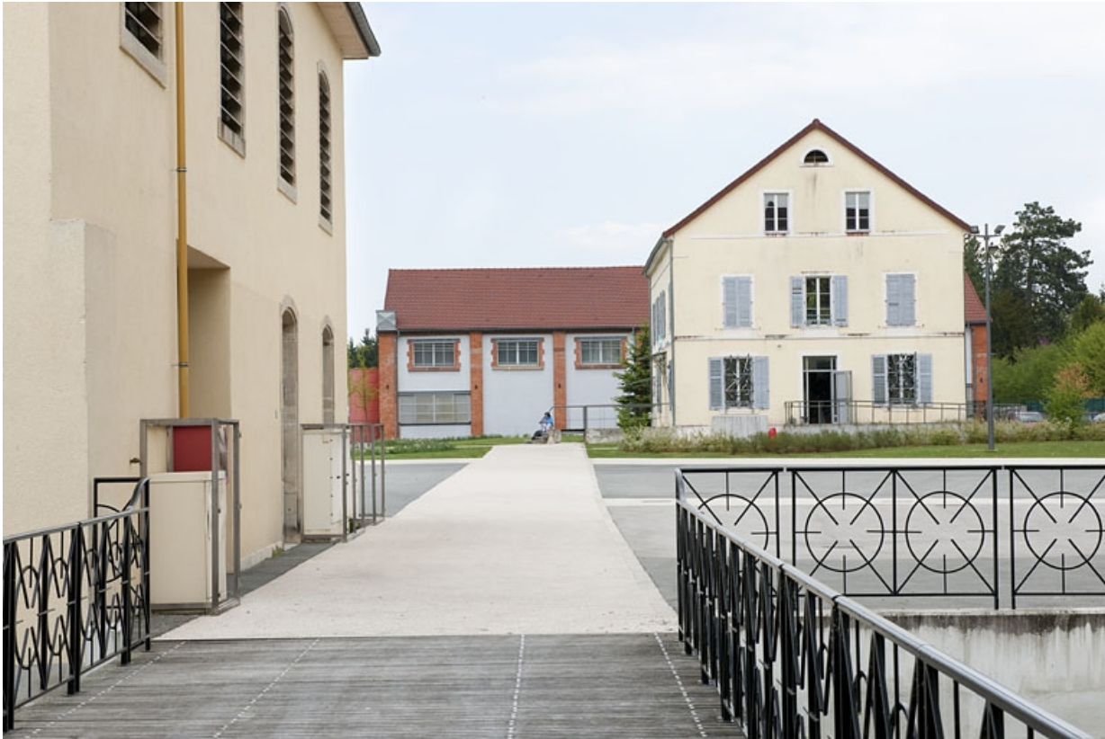
Bureaux et entrepôt industriel depuis l'ouest.
