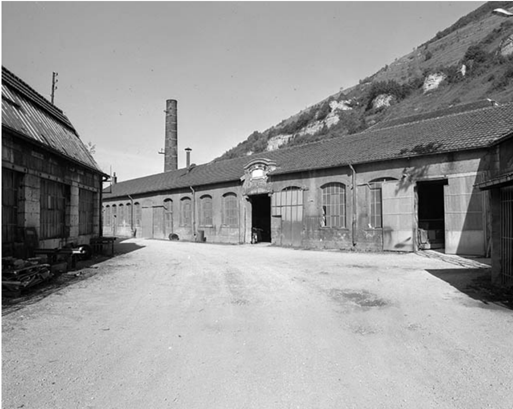
Façade antérieure de la clouterie.
