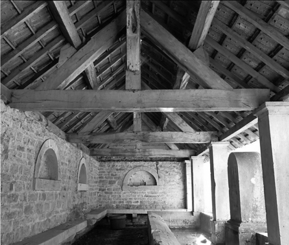
Intérieur : vue de trois quarts droit.
