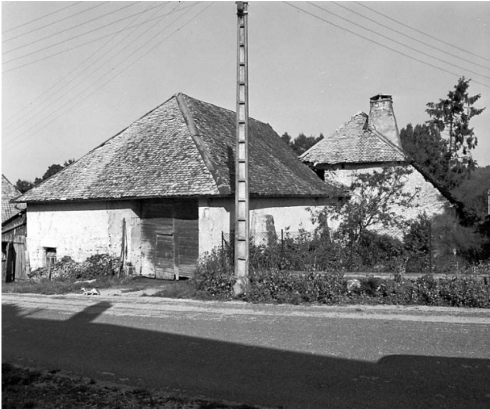
Vue d'ensemble depuis la rue. 25, Trépot
