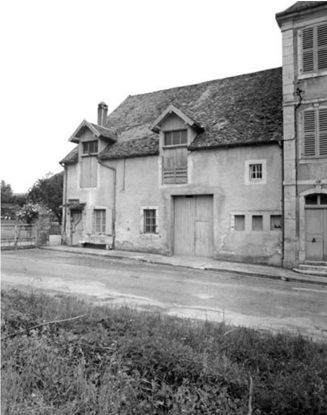
Ferme située 26 rue du Seult.
