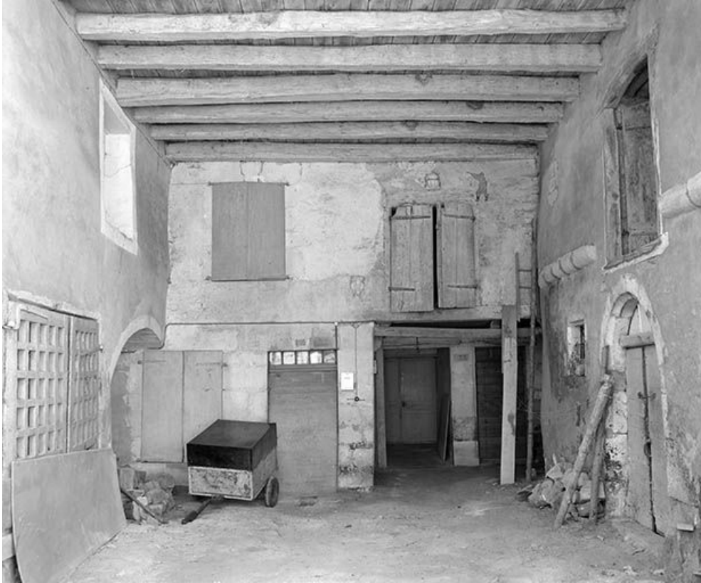
Façade antérieure : le passage plafonné.
