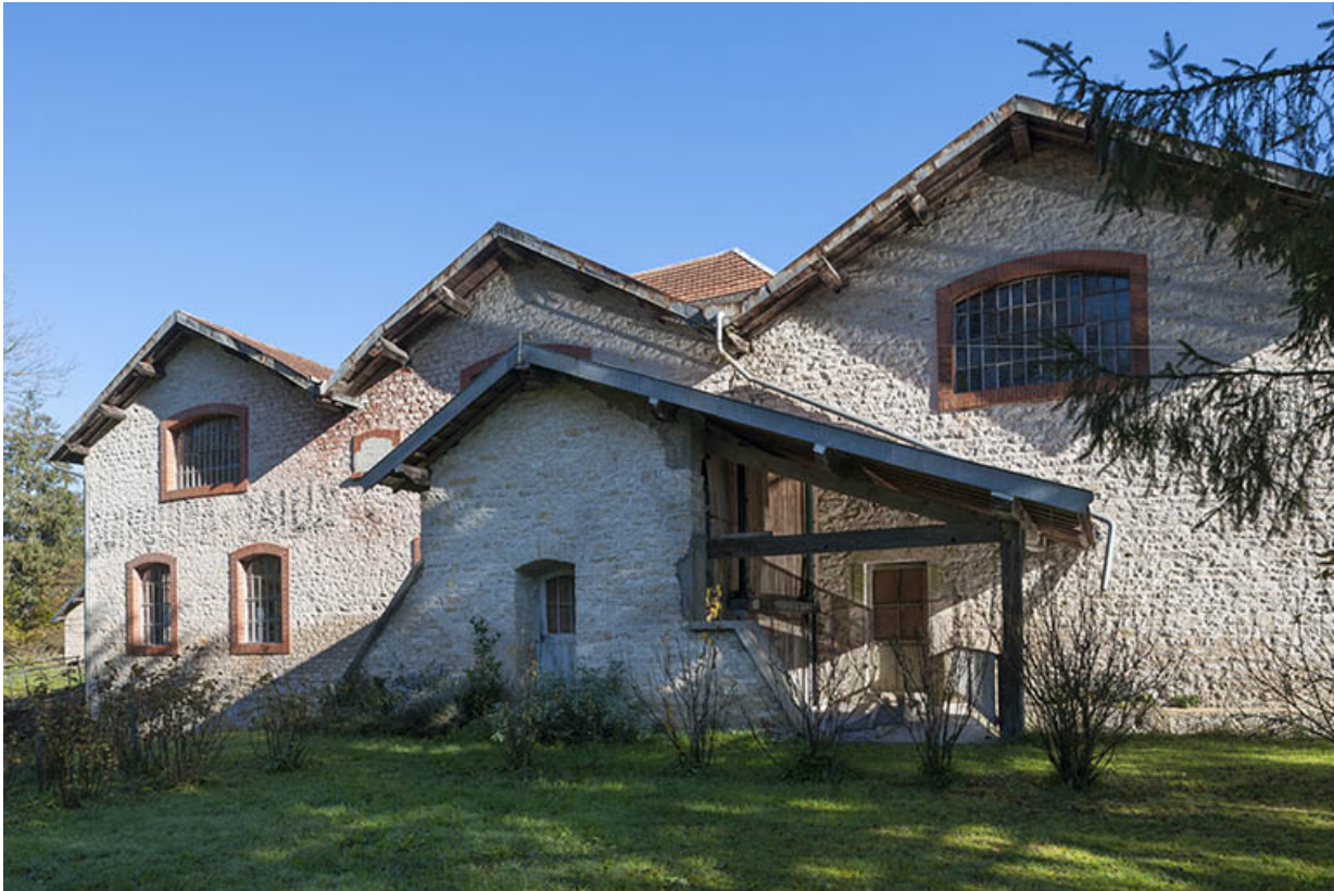
Pignons des bâtiments ouest.
