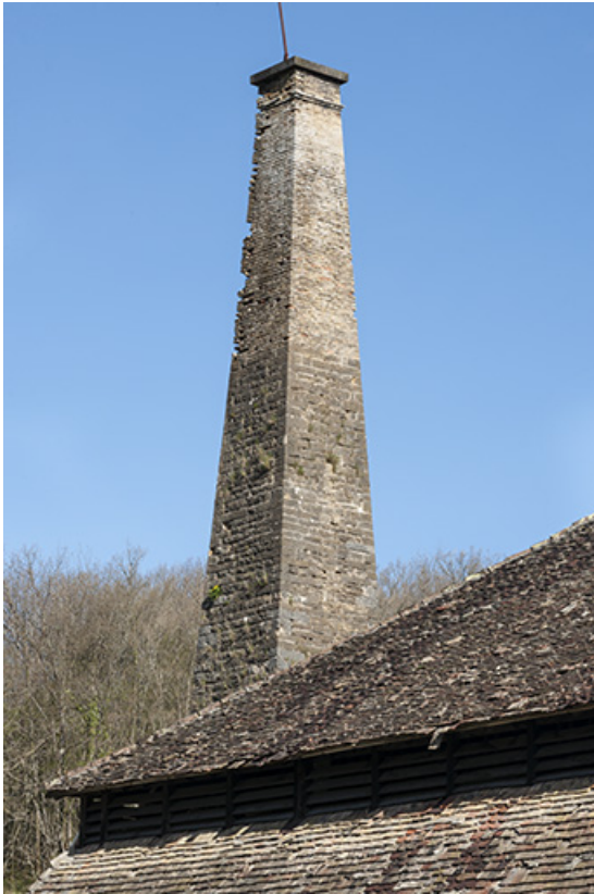
La cheminée de la chaufferie.
