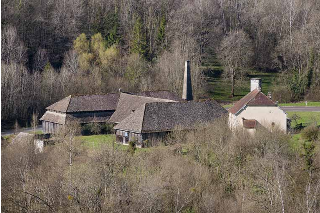
Vue plongeante depuis le nord-est.
