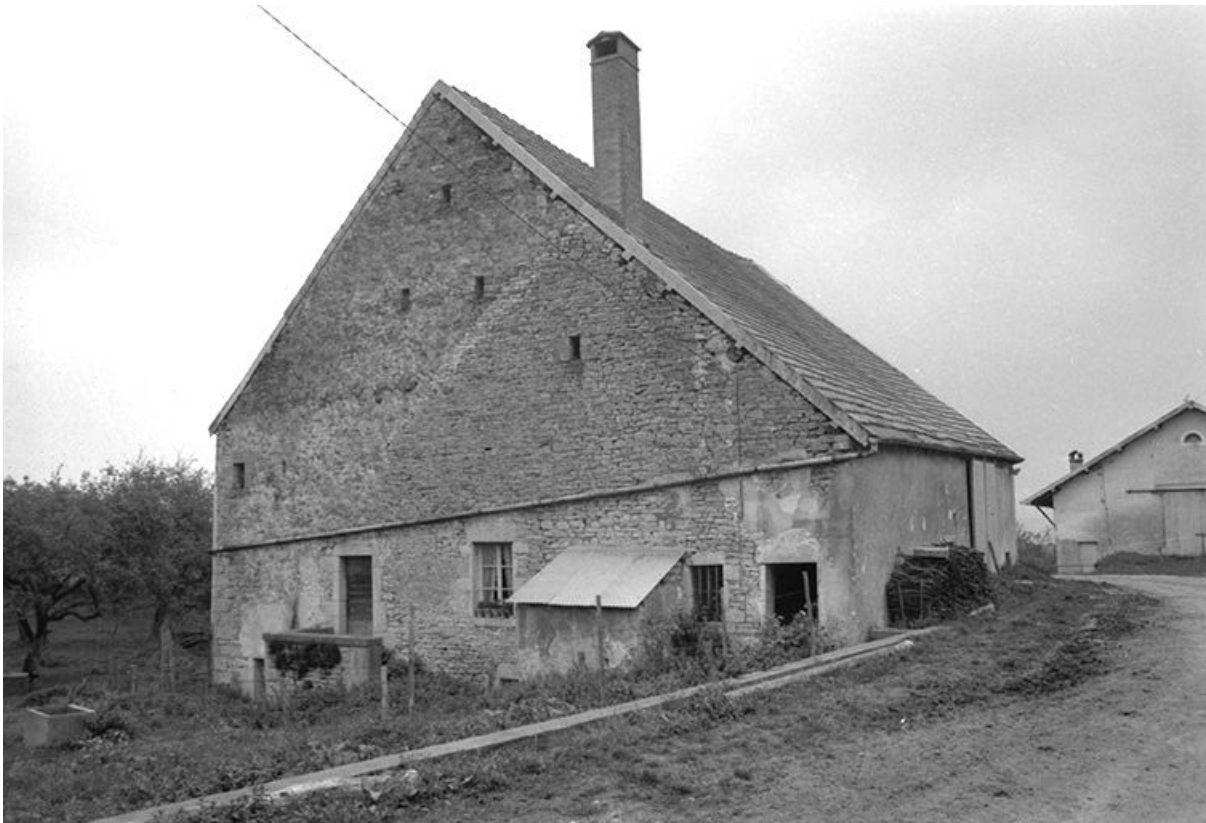
Façade antérieure et face latérale droite. 25, Malbrans
