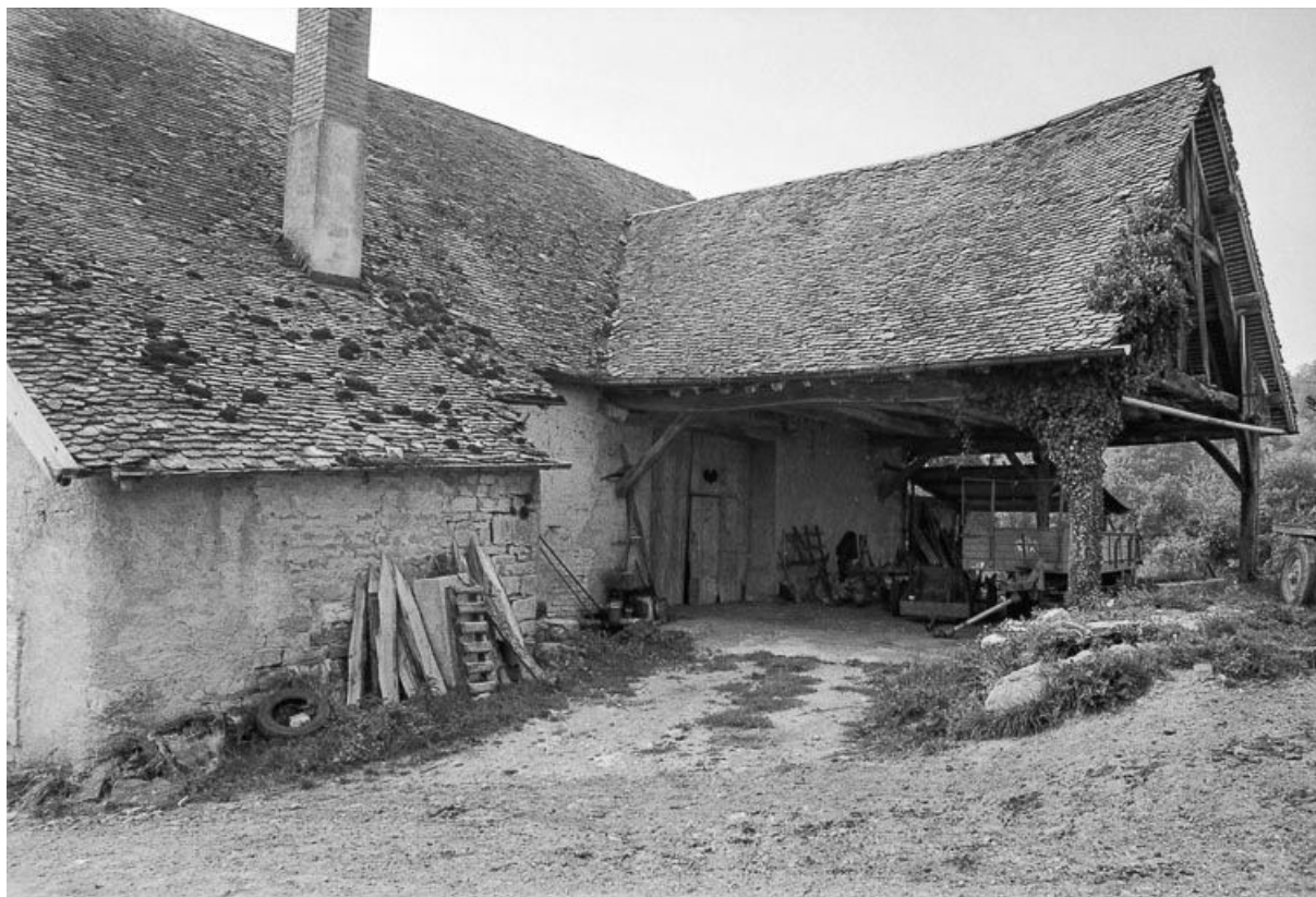
Ferme : vue de la partie agricole.
