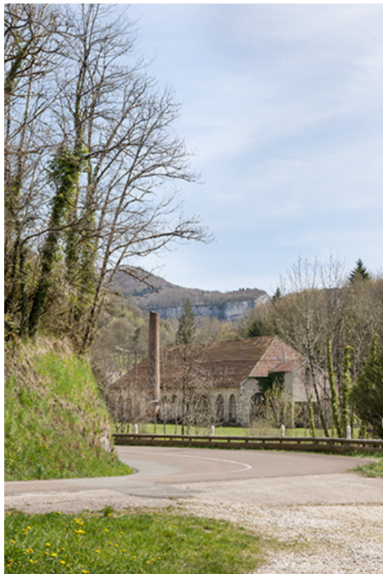
Vue d'ensemble depuis l'ouest.
