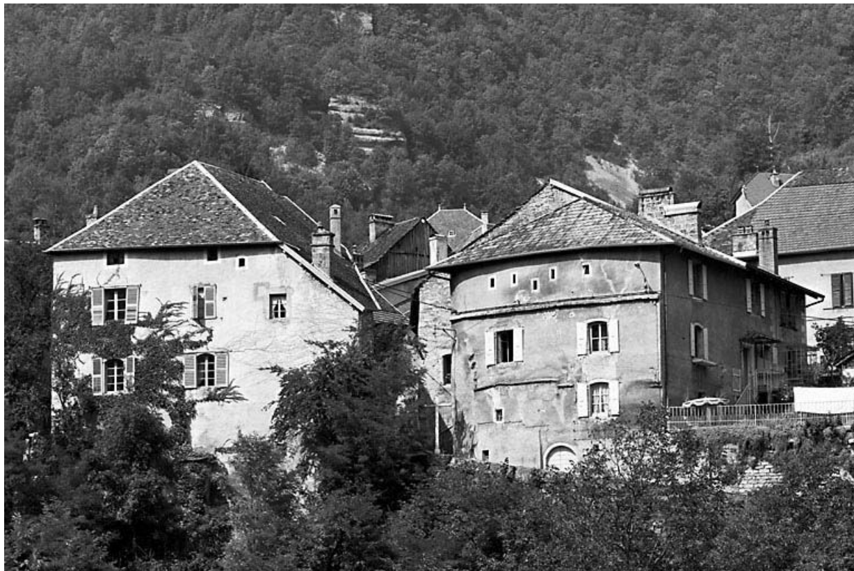
Elévation depuis le sud.
