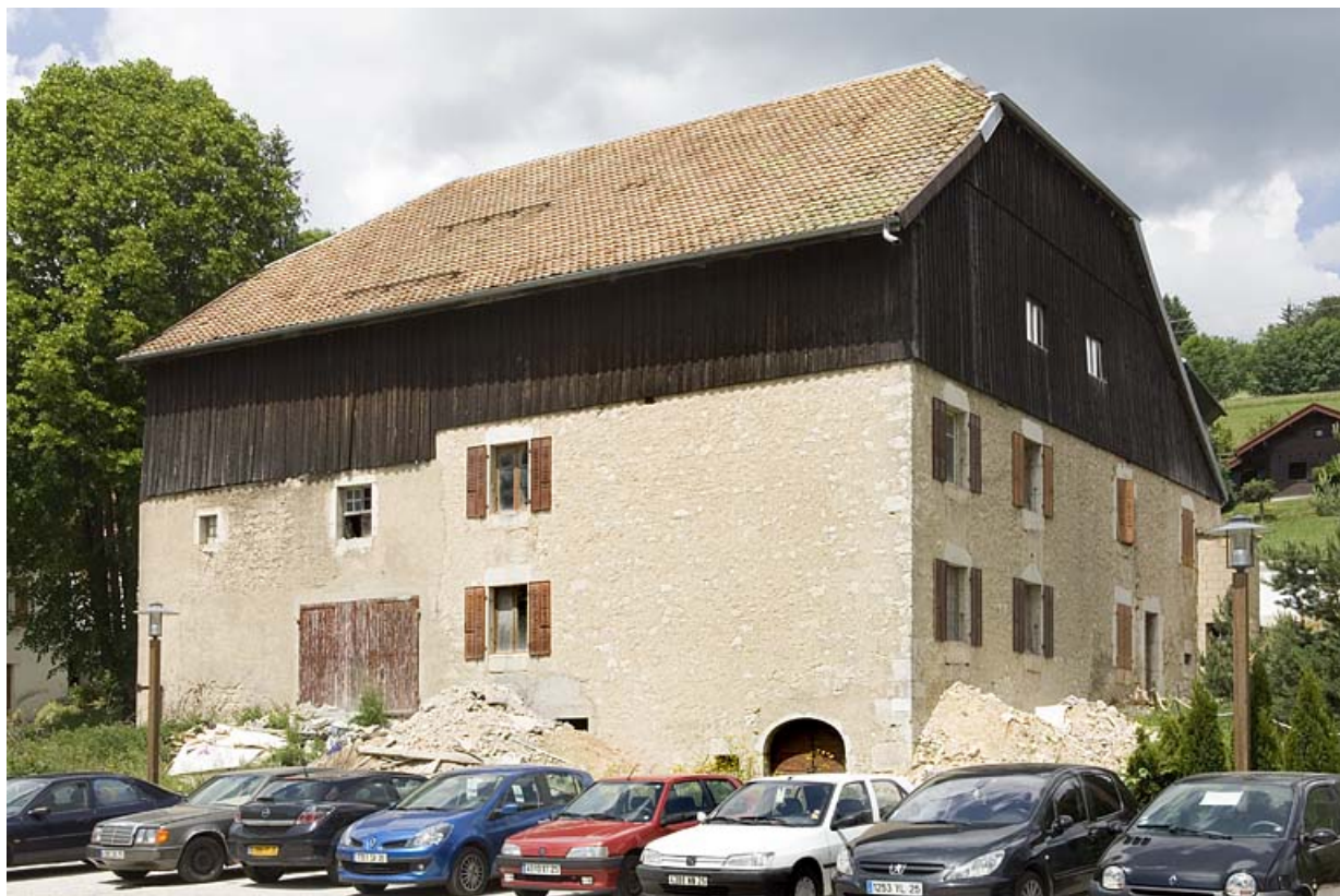
Façades postérieure et latérale gauche.
