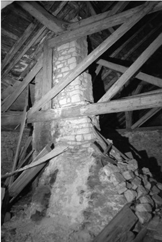
Intérieur : charpente et cheminée.
