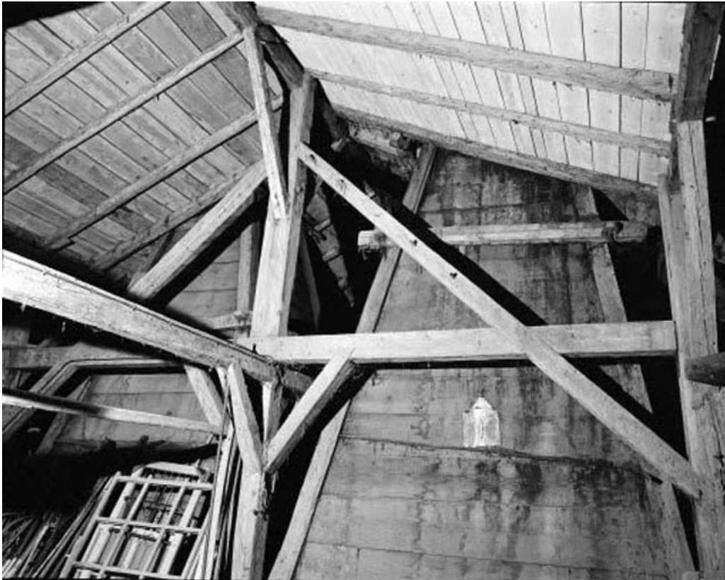
Intérieur : combles, fermes, charpente, hottes des "tués".
