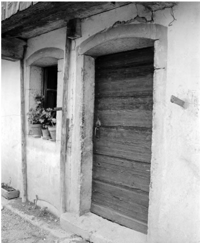
1ère ferme : : porte d'entrée
