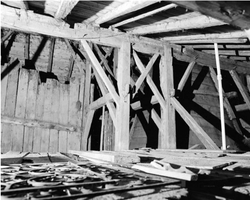
Intérieur : comble, fermes de charpente jumelées en arrière des "tués" au niveau d'une panne. 25, Grand'Combe-Château, lieudit : Bas de Grand-Combe
