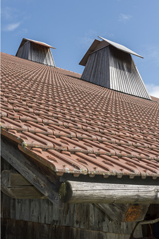
Pan de toiture sud, avec deux "tués".
