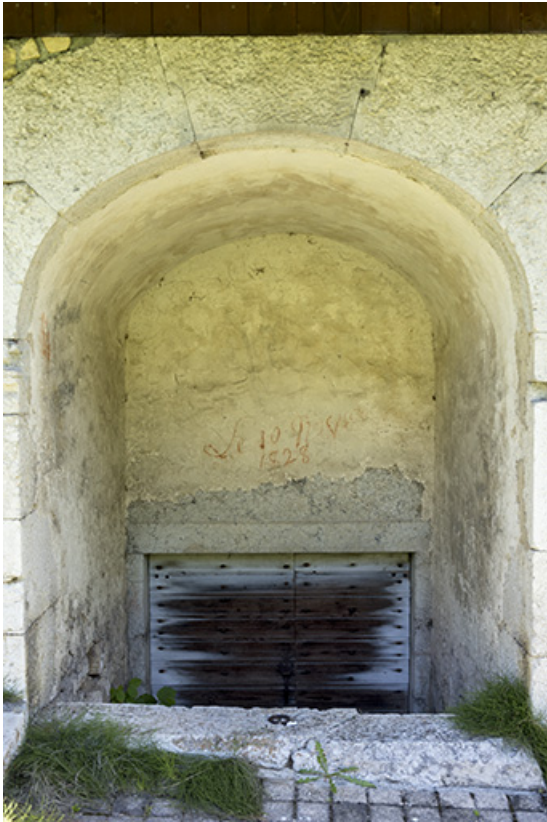
Façade sud : descente de cave et inscriptions.
