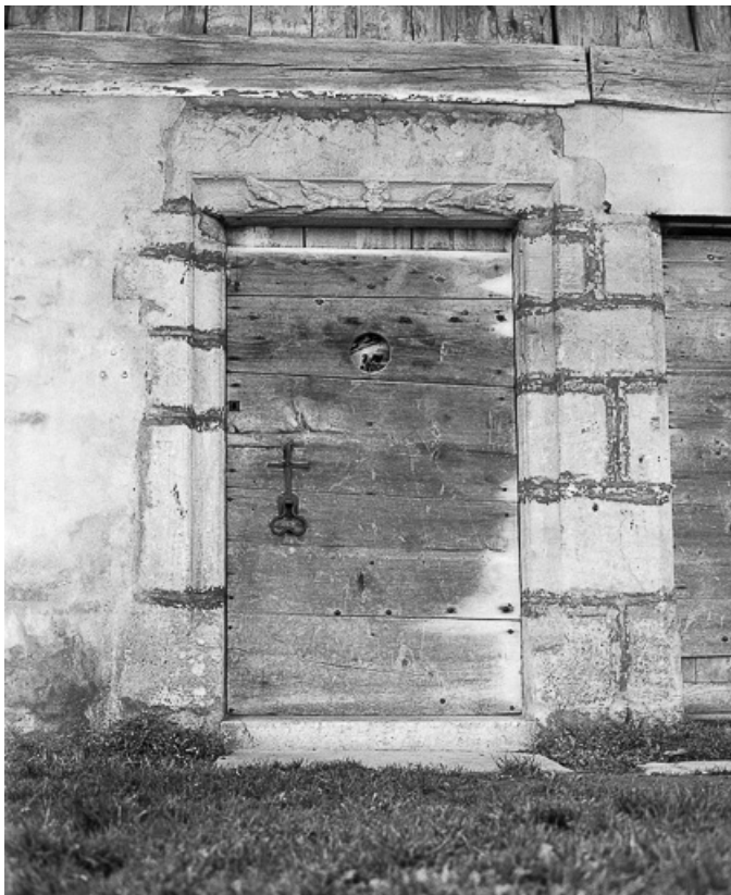
Extérieur : porte sur le mur gouttereau.
