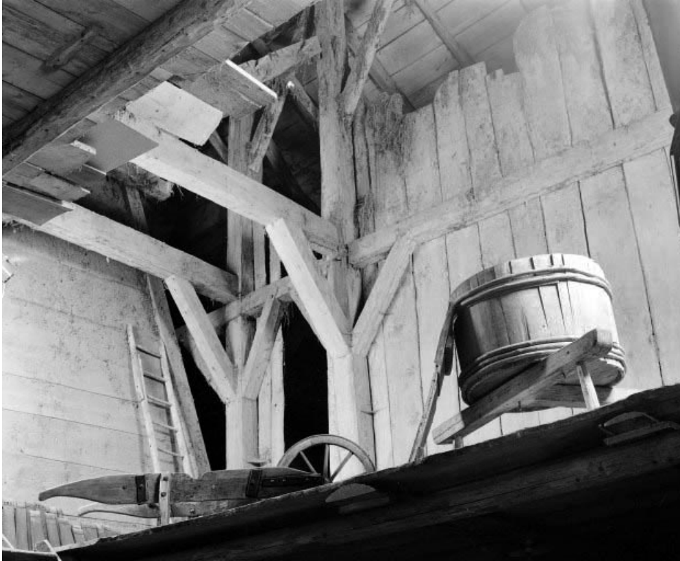
Intérieur : combles, fermes de charpente jumelées en arrière des "tués" au niveau de la faîtière. 25, Grand'Combe-Châteleu, lieudit : Bas de Grand-Combe
