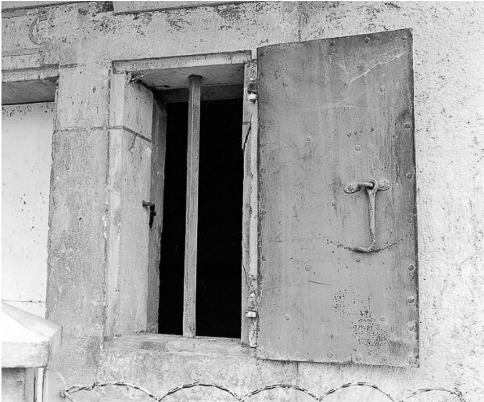
Façade antérieure : volet ouvert de la voûte.
