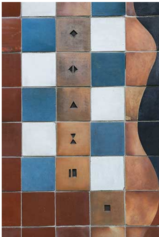
Oeuvre de Bizette. Détail de la façade sur rue.
