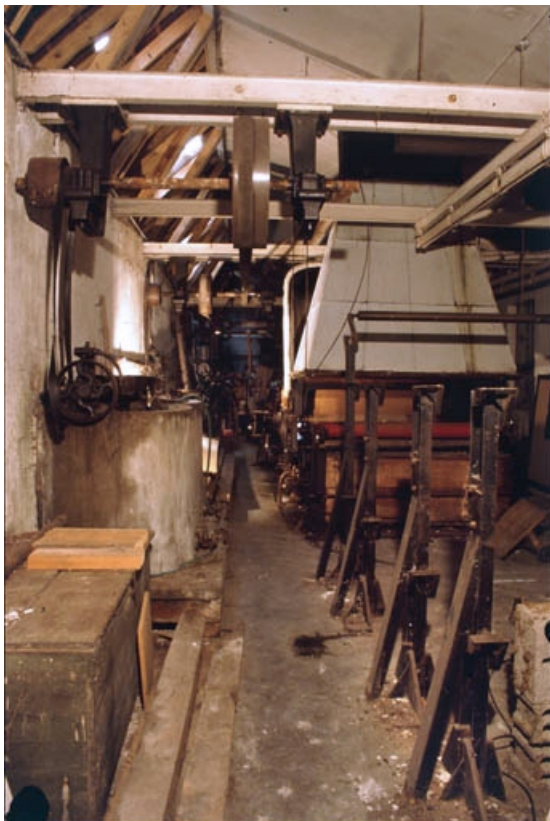
Vue d'ensemble. Au premier plan : porte-bobines.
