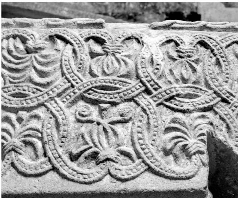
Détail du toit en bâtière. 90, Saint-Dizier-l'Évêque
